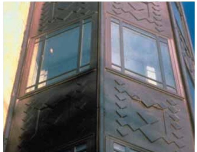
Lepení dekoracních lišt na skleněná okna pomocí 3M VHB TM pásky, dlouhodobě odolávající vnějším povětrnostním podmínkám.
