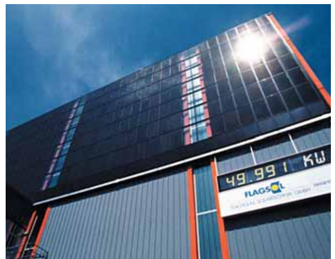
Lepení kovových solárních panelů na kovový rám budovy s použitím 3M VHB TM pásky, která dlouhodobě odolává vyšším teplotám a stálému zatížení ve vnějším prostředí.
