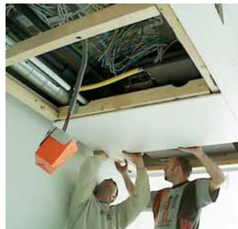
Plastové panely připevněné k dřevěné konstrukci pomocí suchých zipů Dual-Lock™. Efektivní ukrytí elektrických a klimatizačních rozvodů a pohodlný přístup v případě potřeby opravy.
