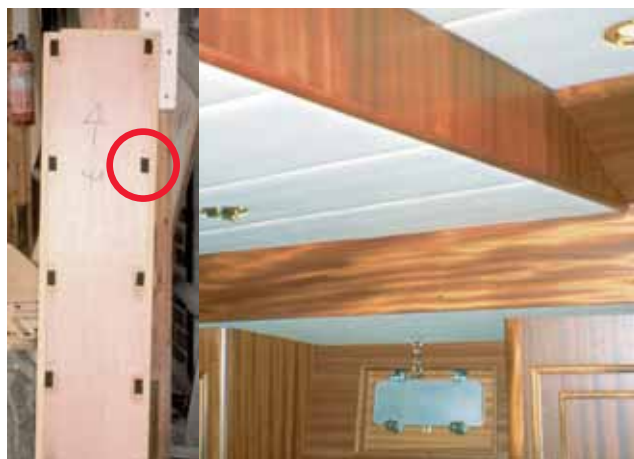
Dotváření interiérů – dřevěné panely jsou připevněny pomocí suchých zipů Dual-Lock™.
