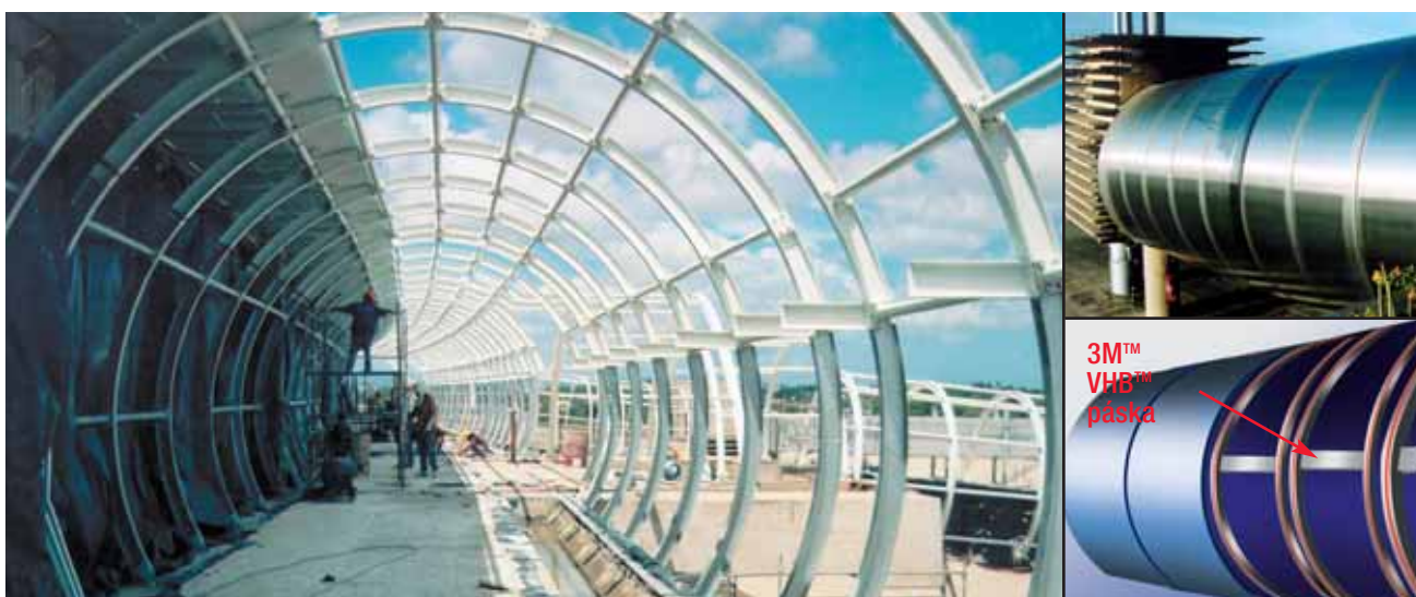
Panely z nerezové oceli lepené na ocelový rám
