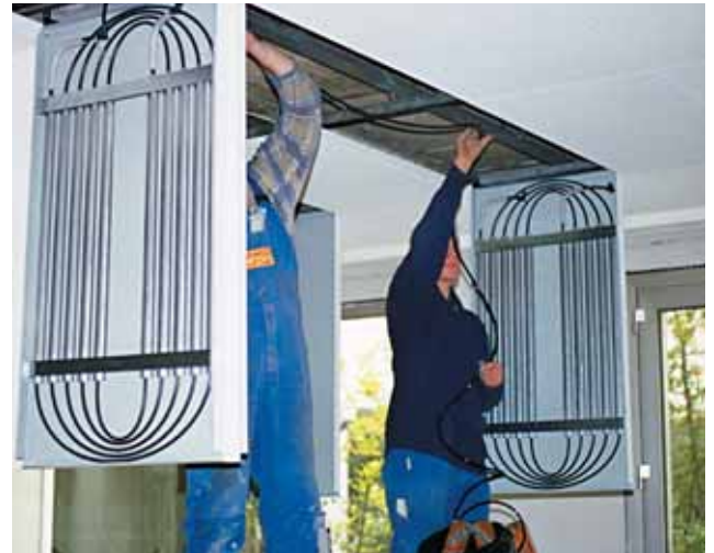
Montáž topných těles do stropních panelů pomocí 3M VHB TM pásky 9473, která dlouhodobě odolává vyšším teplotám.
