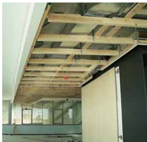
Plastové panely připevněné k dřevěné konstrukci pomocí suchých zipů Dual-Lock™. Efektivní ukrytí elektrických a klimatizačních rozvodů a pohodlný přístup v případě potřeby opravy.
